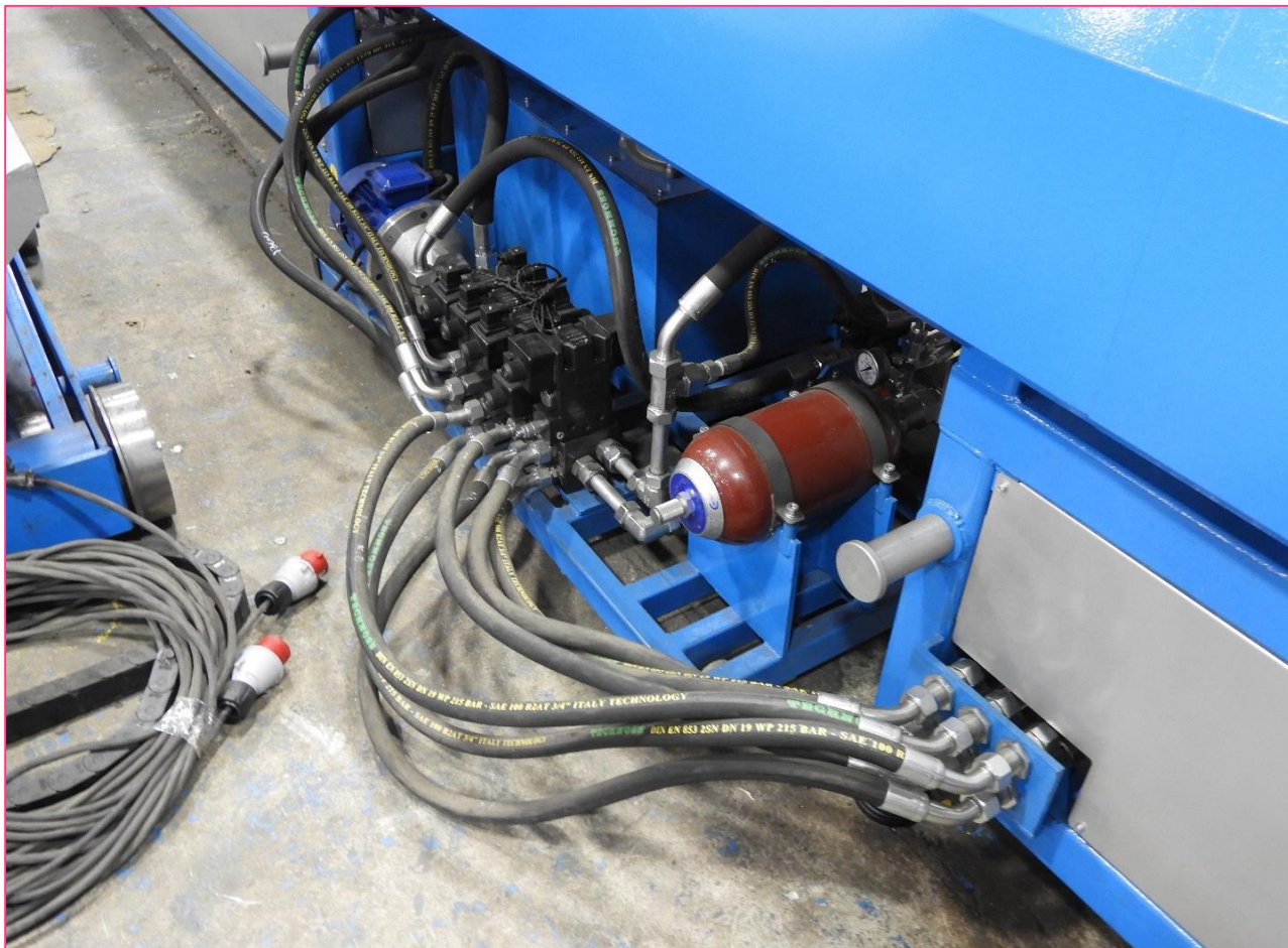
Рис. 9. Гидравлическая станция на выкатной платформе
